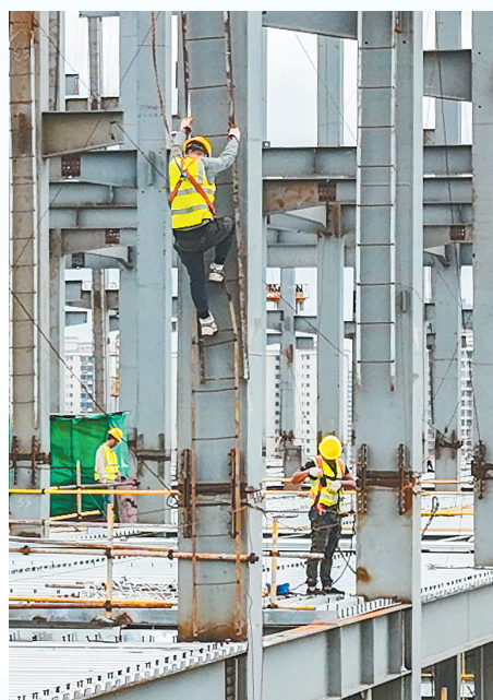
↑↓3月13日，位于澄迈县老城镇的海南生态智慧产业园施工现场，工作人员加紧施工。 本报记者 陈元才 摄
