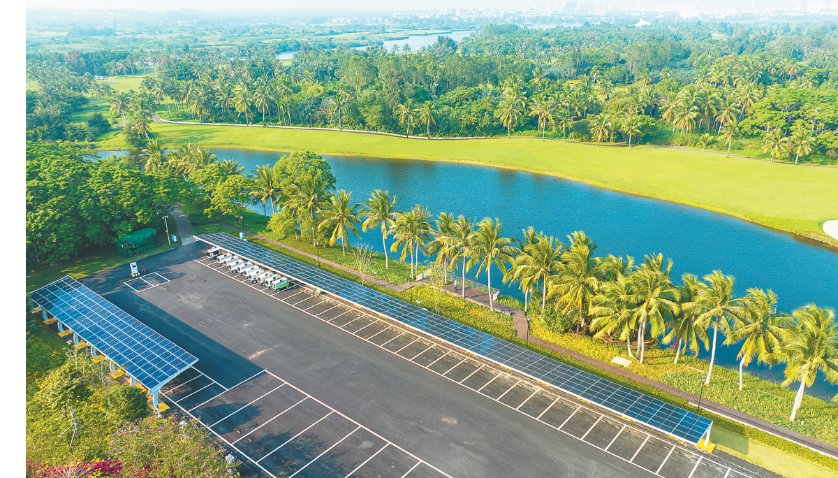
3月17日，在博鳌近零碳示范区，建有光伏发电设备的停车场和新能源充电桩。 本报记者 袁琛 摄
