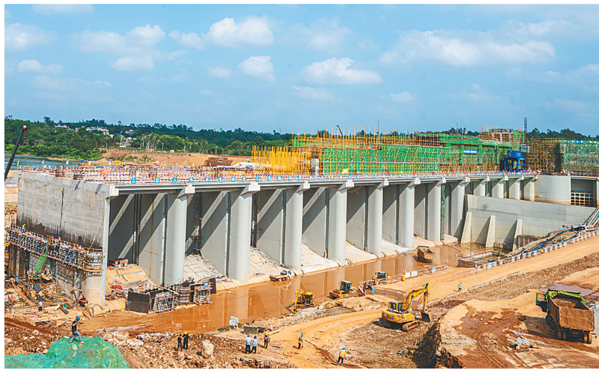
三月二十三日,俯瞰海口市南渡江龙塘大坝枢纽改造工程施工现场。本报记者袁琛摄
