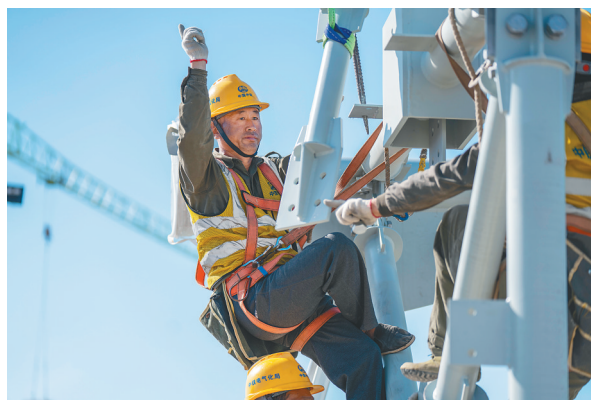
海南国际商业航天发射中心二号发射工位施工现场，建设者在作业。本报记者 袁琛 摄
