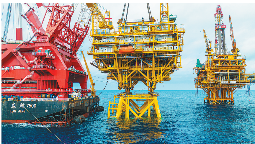
“深海一号”二期工程综合处理平台水上生产组块进行吊装作业。 本报记者 袁琛 摄
