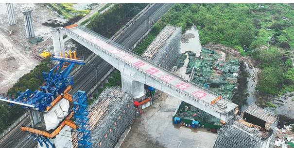
跨汉丹铁路特大桥转体结构呈“T”字型,长113.5米,宽7.1米,总重量超6000吨,是沪渝蓉高铁武宜段汉口至汉川东重难点控制性工程之一。沪渝蓉高铁武宜段汉口至汉川东全长44.535公里,由中铁十二局集团有限公司承建,包含多处转体桥、斜拉桥等特殊结构物。图为4月2日,沪渝蓉高铁武宜段汉口至汉川东西南下行联络线跨汉丹铁路特大桥转体完成。 新华社发
