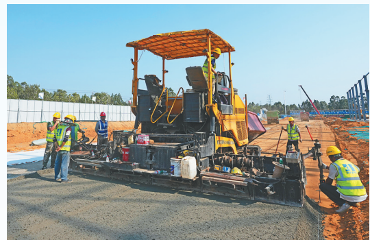
三一湘琼(海南)智造产业园项目施工现场。 本报记者 陈元才 摄
