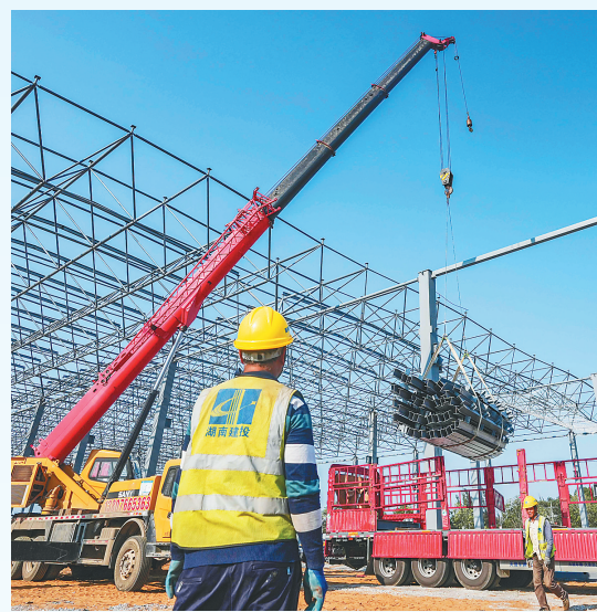
数台大型吊车正在联合厂房施工区吊装屋面钢网架。 本报记者 陈元才 摄
