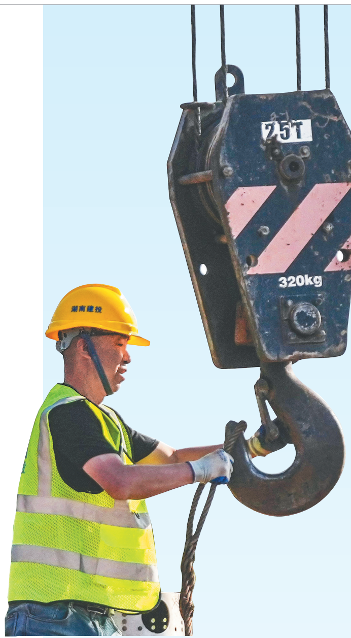
近日,工人在三一湘琼(海南)智造产业园项目施工现场忙碌。 本报记者 陈元才 摄
