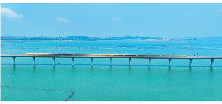
2023年6月28日,CR450动车组试验列车在涠洲湾跨海大桥交会运行,单列最高运行时速达到453公里。 新华社发
