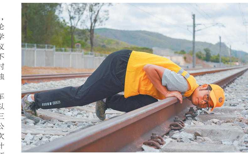
肖凯在崖州湾站作业，查看轨道高低是否平整。张嘉豪 摄 焊接头进行严格把关，盯紧焊接工序，发现焊接质量达不到工艺标准要求时，及时要求进行重焊，确保焊接质量达标，确保三乐线施工站改焊接项目圆满完成。作为工长，肖凯始终保持着“为有才
