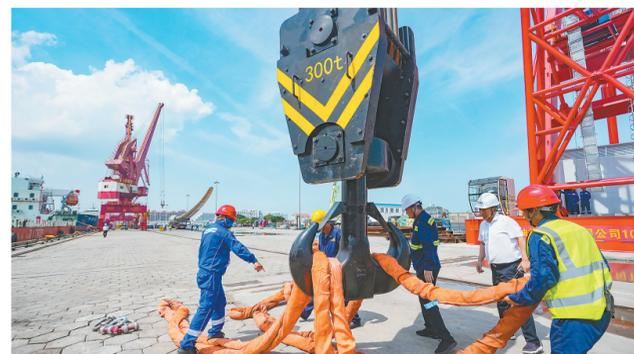
5月7日，工作人员在起重机吊钩上拉好钢缆以便吊运风轮叶片。
