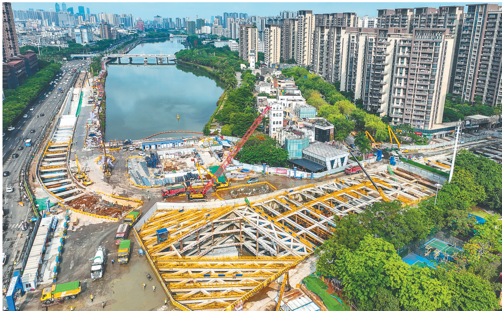
海口白龙路下穿通道工程 总进度完成65%
