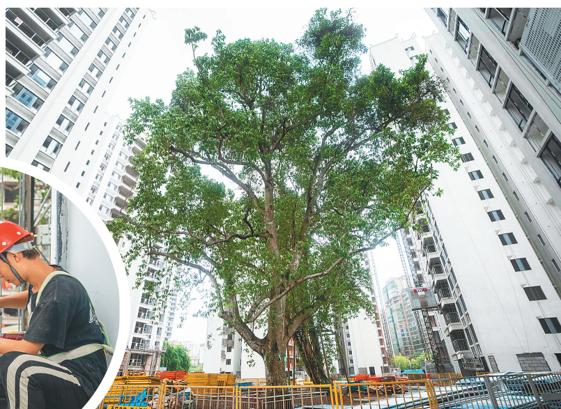
5月8日，在海星·安悦兰亭安居房项目现场，工人在施工作业。目前项目已进入全面装修阶段。 本版图片除署名外均由本报记者 袁琛 摄
