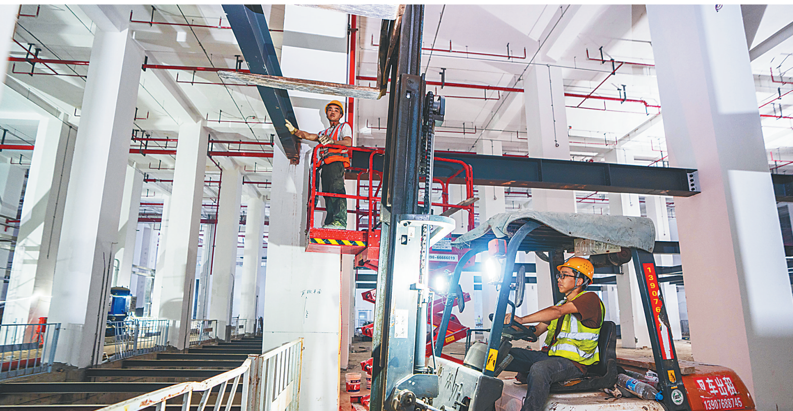
日前在海口市江东新区高品质饮用水水厂项目现场，工人进行内部装修施工。本报记者袁琛摄
