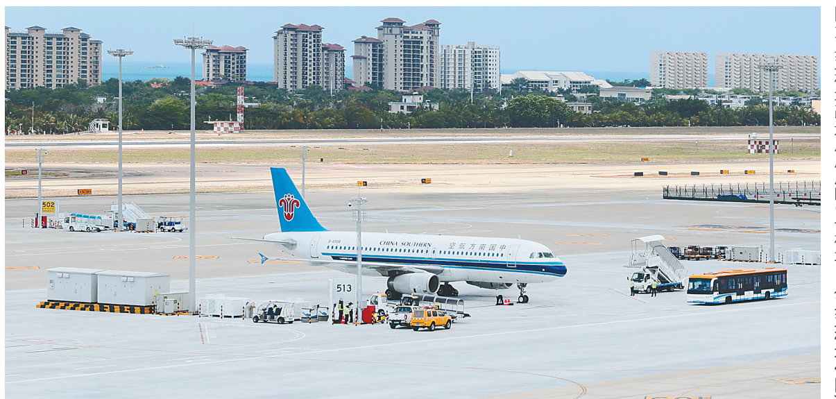
图为三亚机场改造后启用的S5号机坪。（三亚机场供图）
