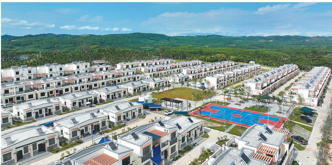
屯昌中坤荔枝园安置点。本组图片均由 林小丹 供图
