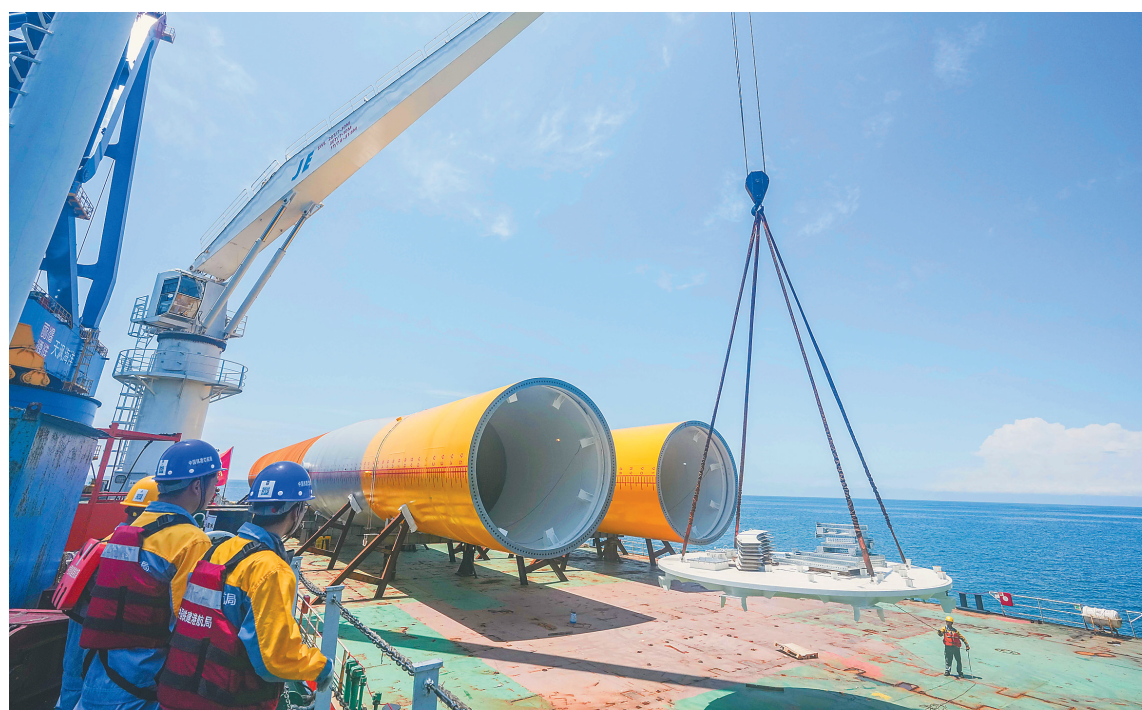
近日，在位于儋州北面海域的申能海南CZ2海上风电示范项目现场，工作人员正有序开展风机钢管桩沉桩工作。海上风电装机提供固定式基础支撑。 本报记者 陈元才 通讯员 王小军 摄
