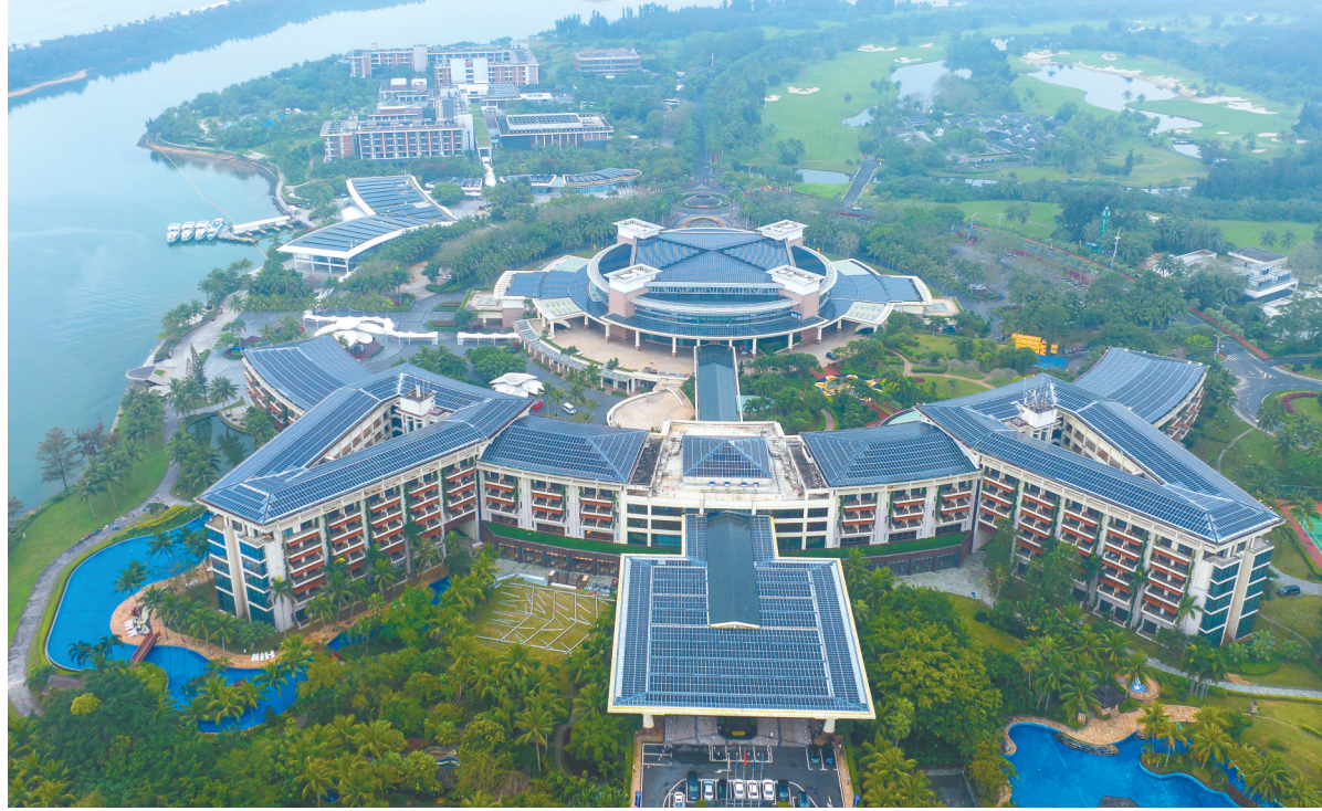
俯瞰博鳌近零碳示范区，场馆屋顶被可发电的光伏板覆盖。（资料图）
