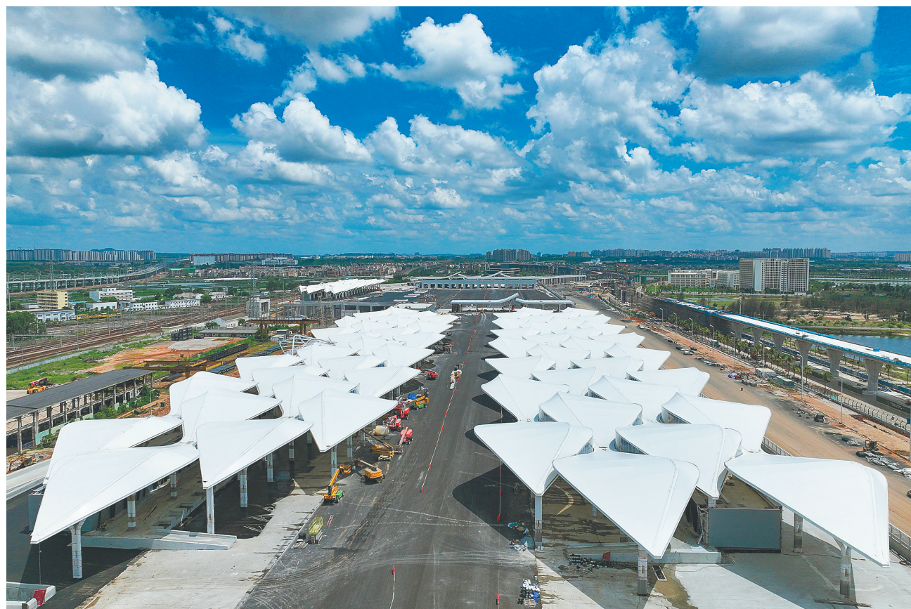
封关运作建设项目：最大基础性工程初具雏形。日前，俯瞰海南自贸港封关运作建设项目中最大的基础性工程——海口新海港和南港“二线口岸”(货运)集中查验场所。目前，该项目正在进行装饰装修、机电安装和膜结构施工等收尾工作。本报记者 王程龙 摄
