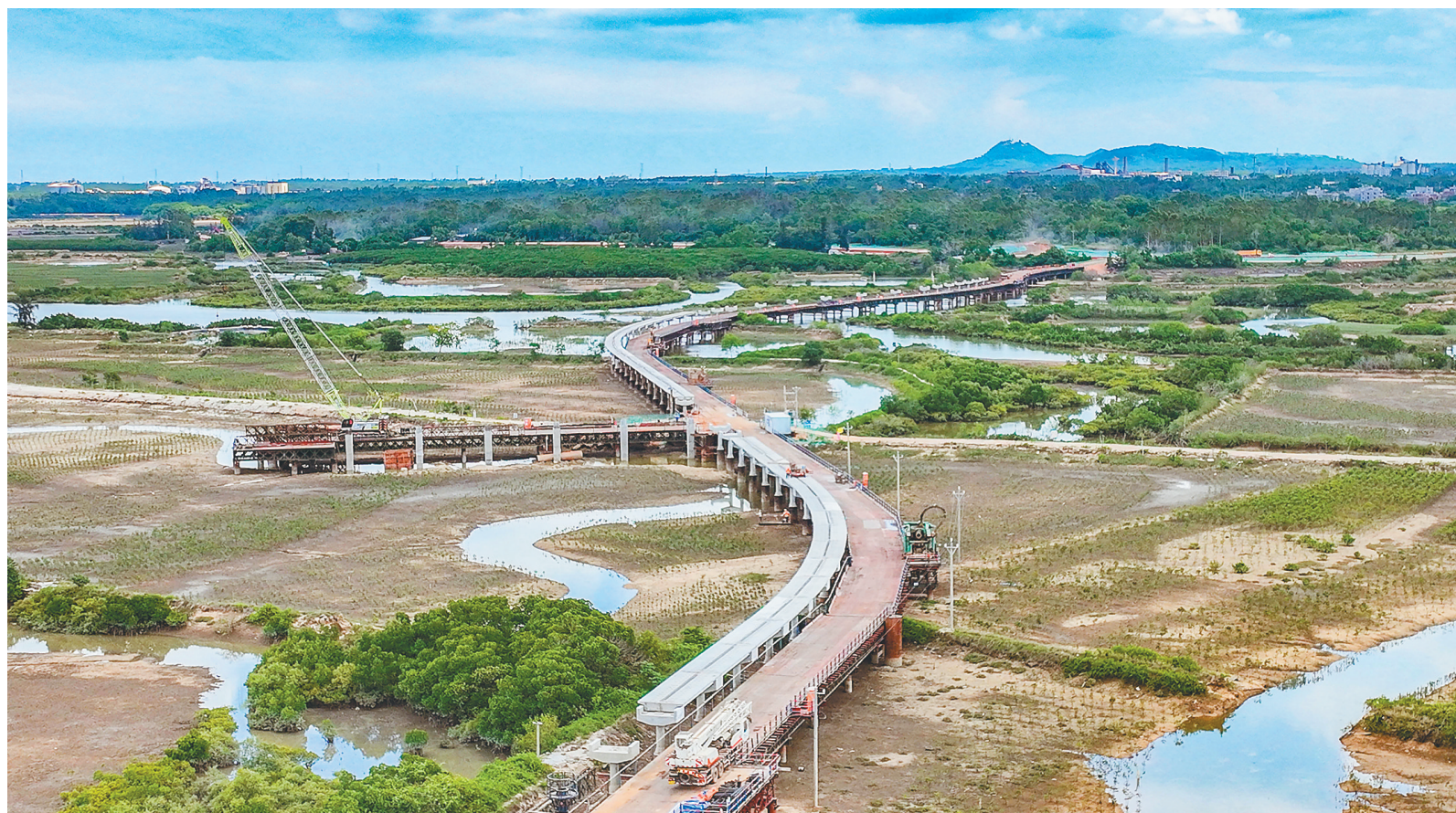
近日，航拍位于儋州市的环岛旅游公路环新英湾支线北门江大桥项目。该工程目前正在加紧建设，已全面开展桩基、承台、下部结构施工，梁片预制及架设也有序跟进。
