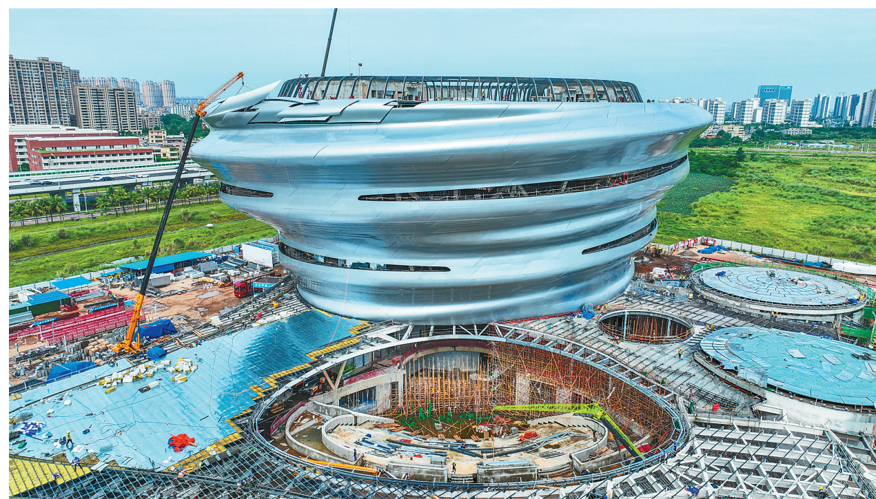
海南科技馆 冲刺月底建筑工程完工 “祥云”落海口
