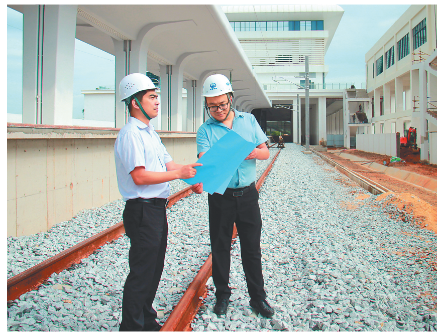
近日,符跃忠(左)在南港站检查施工作业情况。
