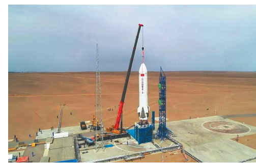
图为吊装现场。(中国航天科技集团八院供图)
