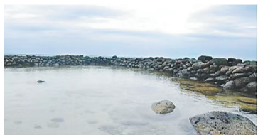
儋州干冲地区的石冲堤坝。 王辉山摄
