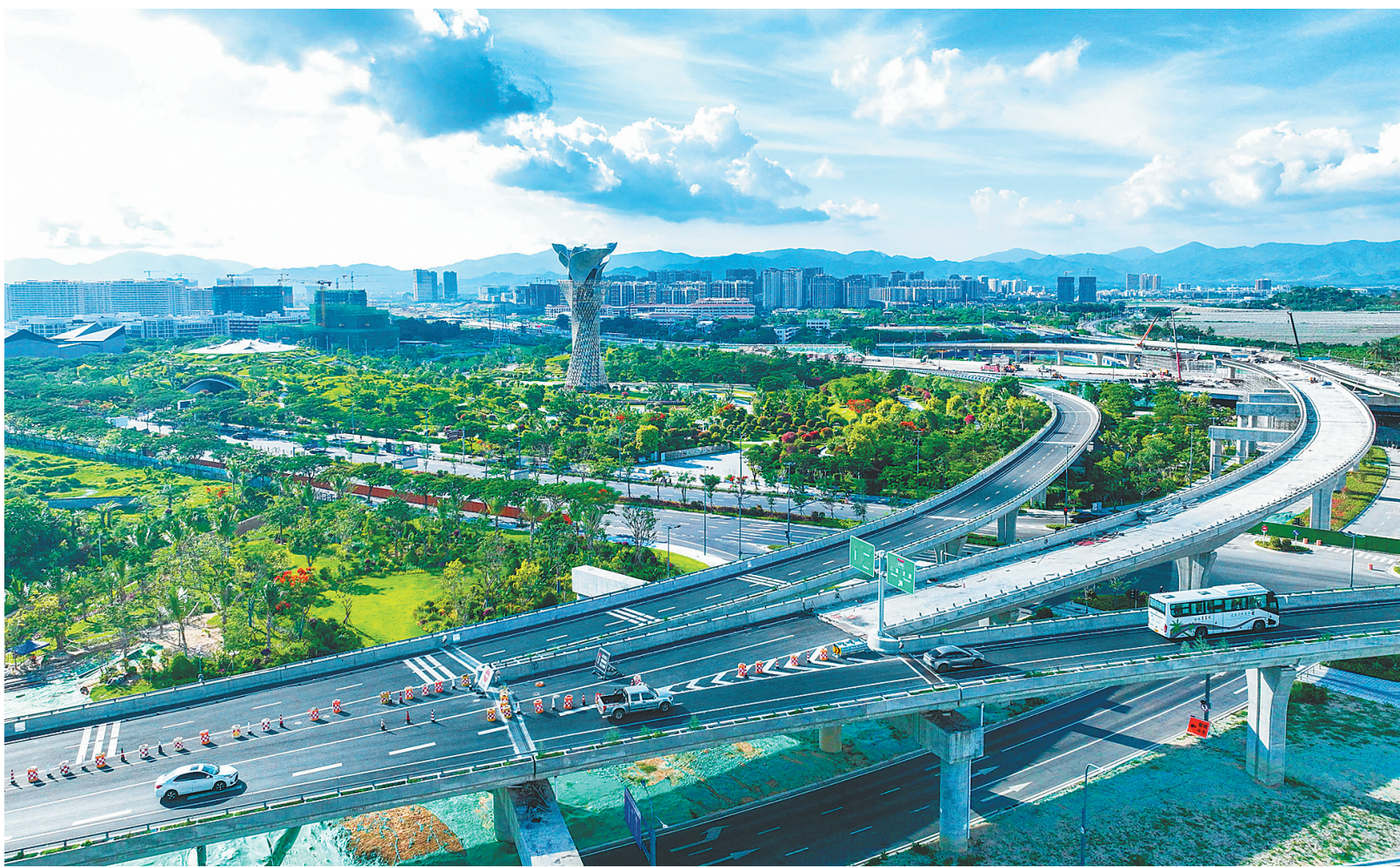
近年来,三亚崖州湾科技城加快完善园区基础设施,为企业提供便利。图为近日拍摄的G98环岛高速(崖州段)改建工程项目现场,该项目预计8月底全面完工。 本报记者 王程龙 摄
