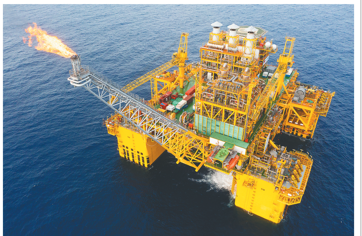
航拍“深海一号”能源站。 中国海油供图
