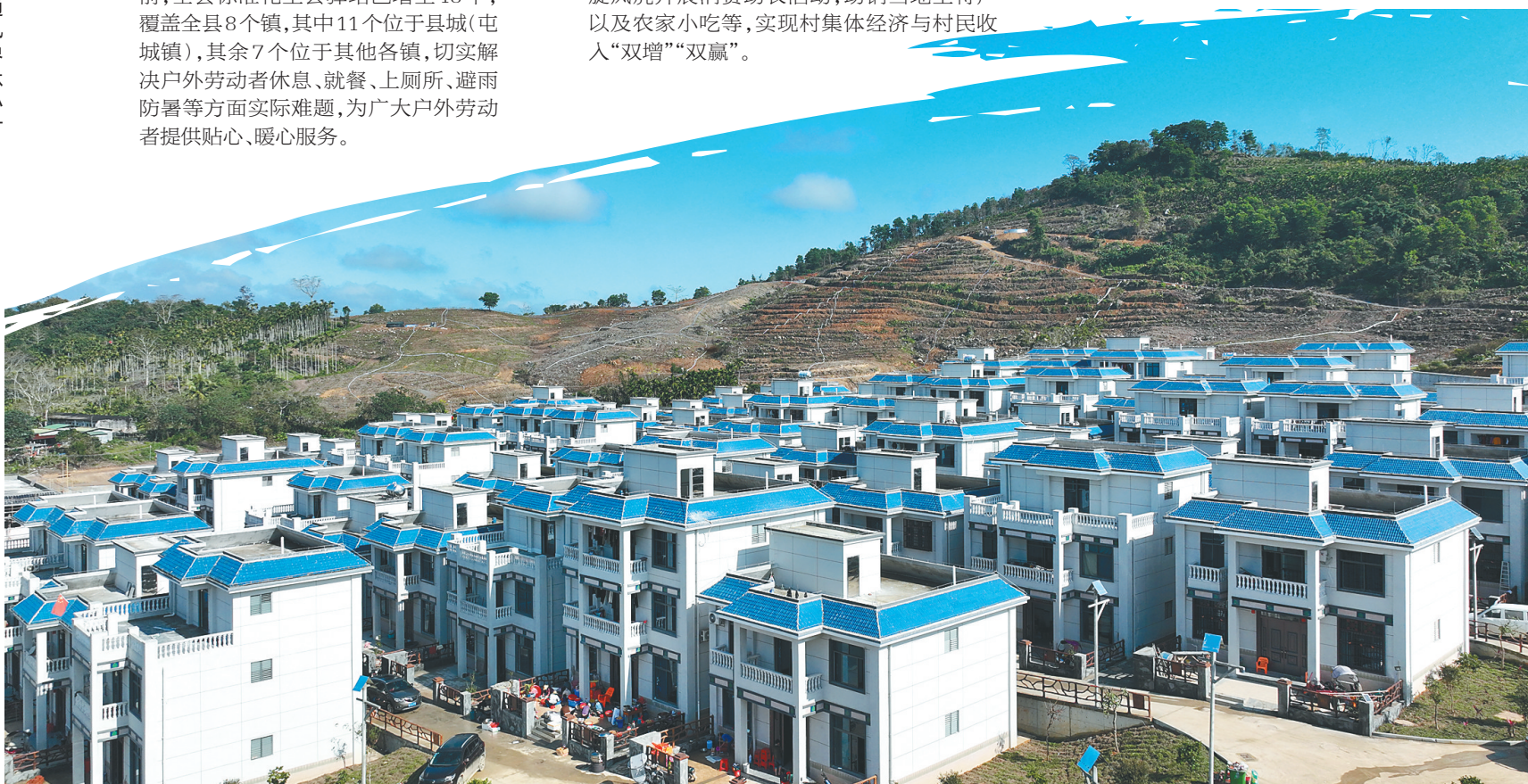
合水新居如期建成投用。 本组图片均由通讯员 林小丹 摄
