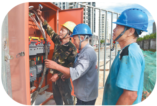
工人在海馨家园安装配电箱设施。
