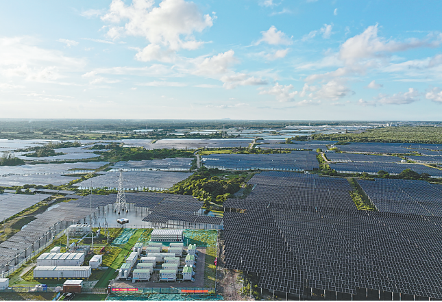
海南华林文昌100MW农(渔)光互补项目光伏场区。
