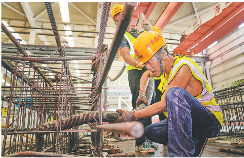
近日，在临高金牌港开发区的装配式建筑生产车间，工人正在进行装配式建筑产品的浇筑生产。
