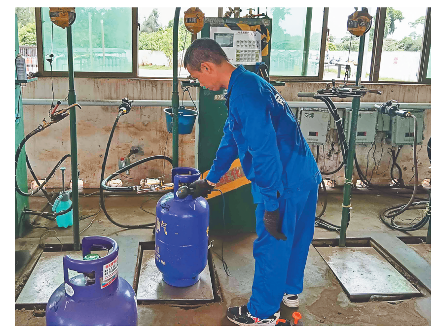
海南民旺气站工作人员正在充装液化石油气。
