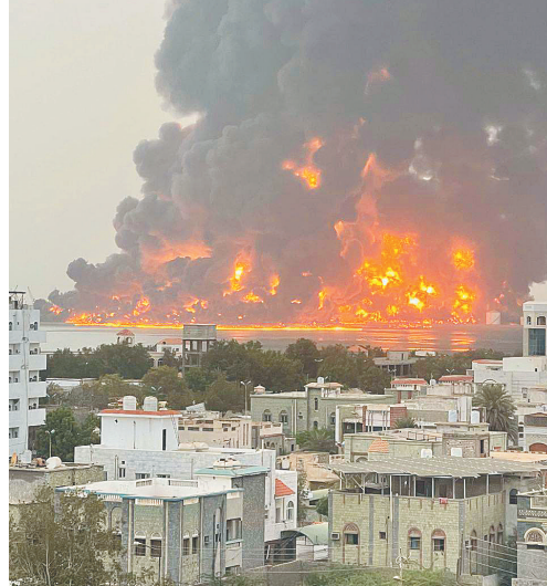
据也门胡塞武装控制的马西拉电视台7月20日报道，也门红海城市荷达的港口区域当天遭到以色列战机空袭，目前已造成至少80人受伤。图为也门红海城市荷达的一处储油设施在遭空袭后引发大火。新华社发
