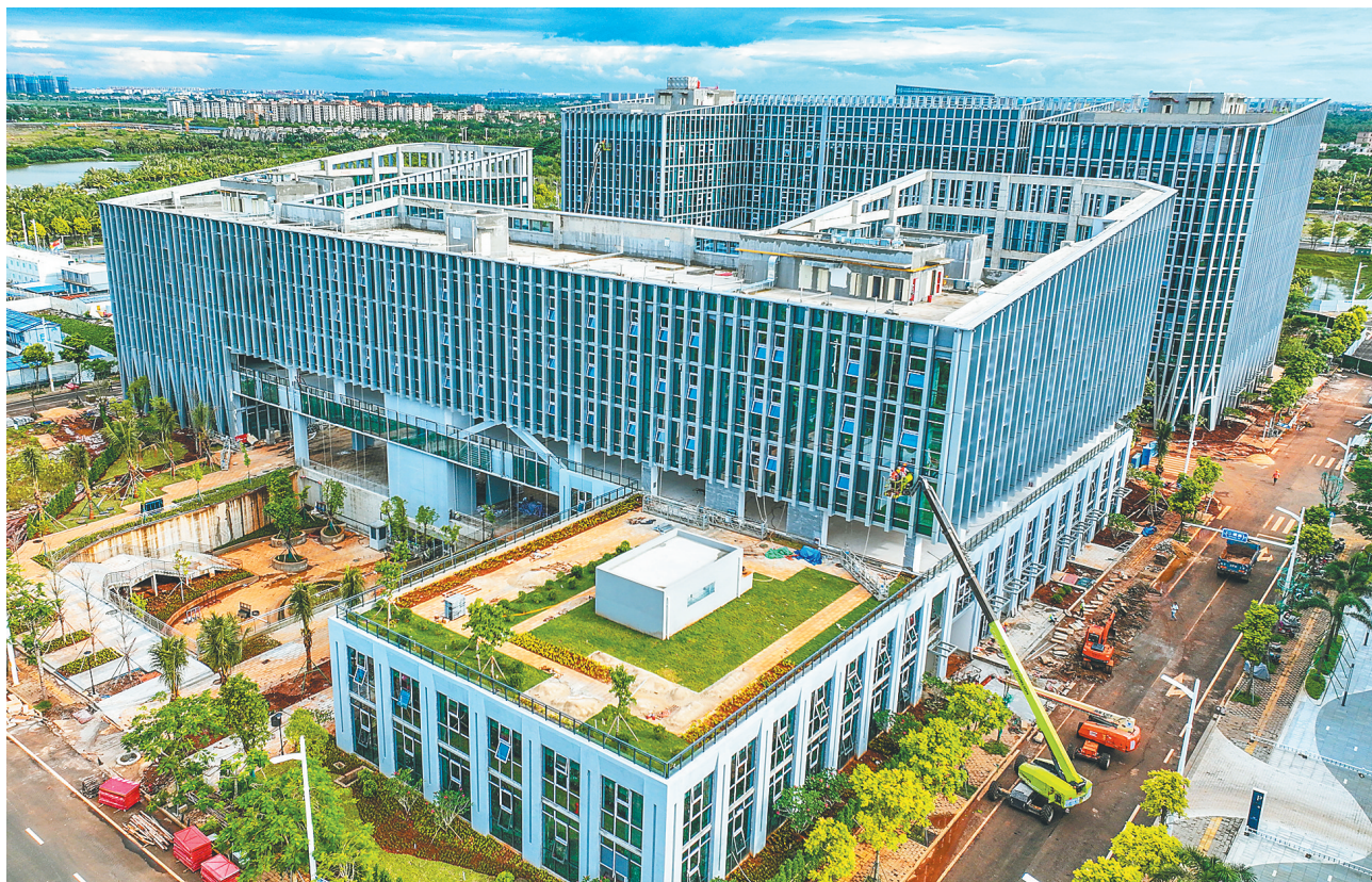
7月25日，位于海口江东新区总部经济区(生态CBD)的南方电网公司新型电力系统研发中心项目已建成完工，正在进行最后的收尾工作。 海南日报全媒体记者 张茂 特约记者 王聘刊 图/文
