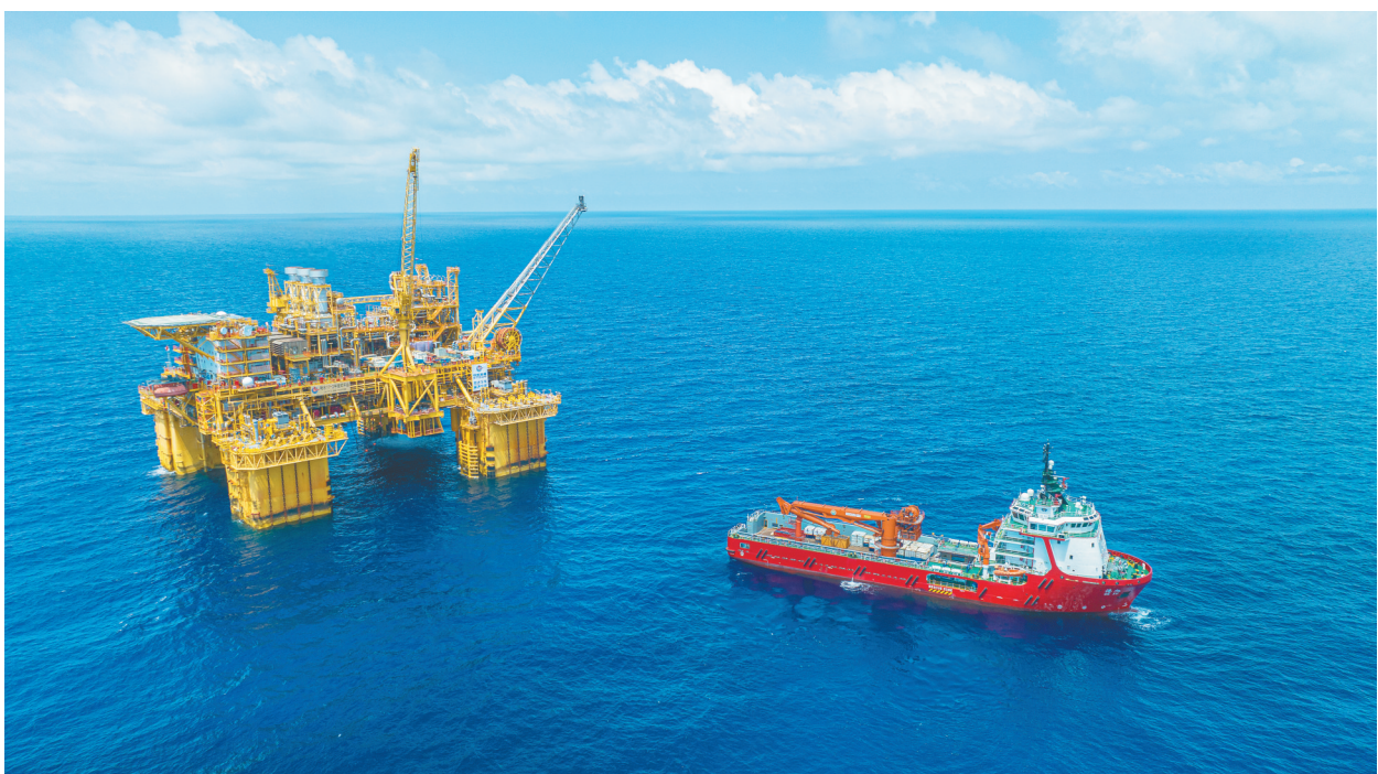
在海南东南部海域，总高度120米、总重量超5万吨的全球首座十万吨级深水半潜式生产储油平台——“深海一号”能源站傲然矗立，这是我国首个自营超深水大气田。
