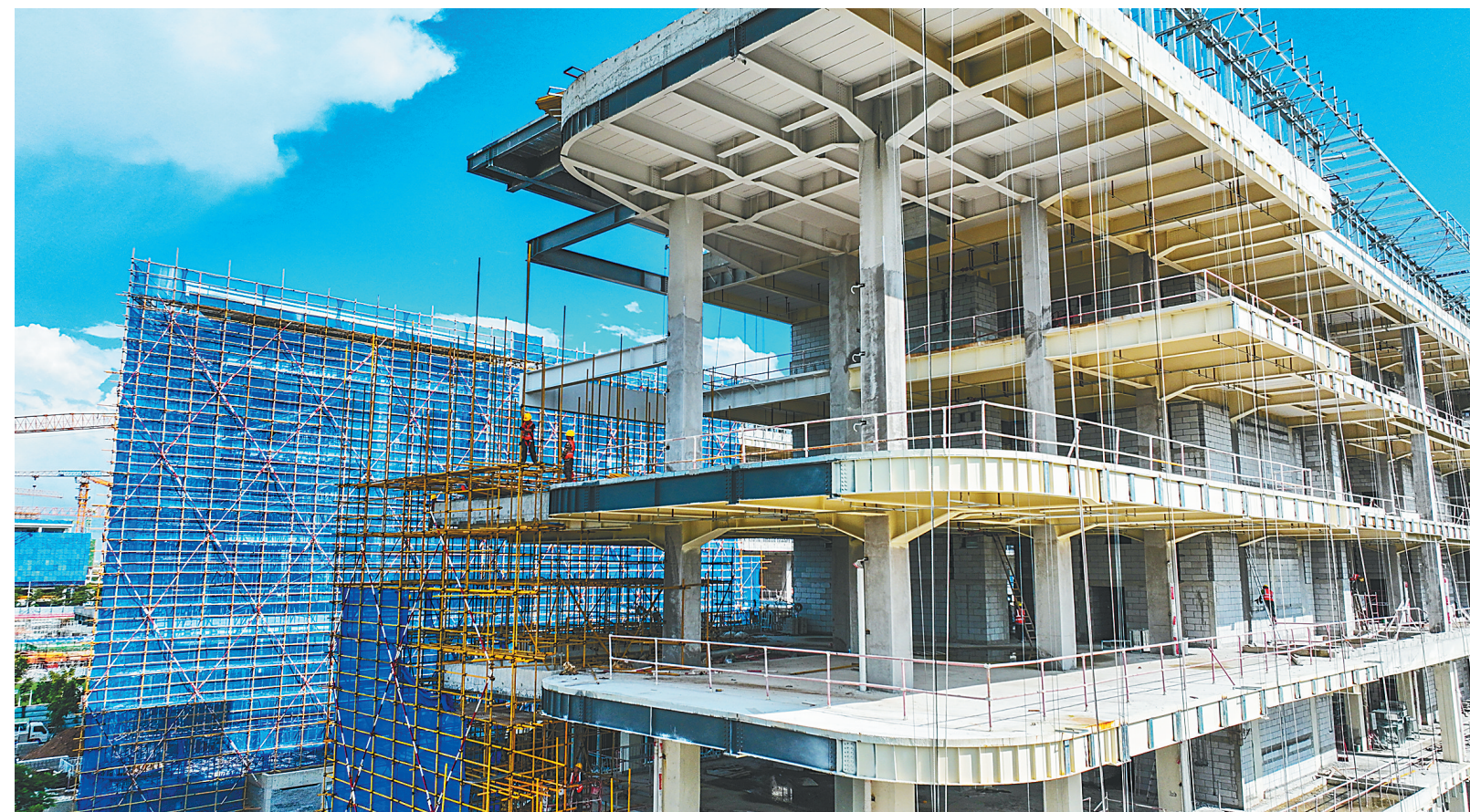
近日,位于海口江东新区总部经济区(生态CBD)的江东天地项目实现主体结构全面封顶。该项目占地面积约43.7亩,将建成集城市高端办公、精品商业、文化娱乐、艺术展示等为一体的城市综合体项目。据了解,该项目分为3个地块,每个地块都有两栋单体建筑,其中1-4号楼地上钢结构已于上半年陆续封顶,正在进行机电设备安装等工作;5号、6号楼近日完成封顶,下一步将开展砌体工程。 海南日报全媒体记者 张茂 摄
