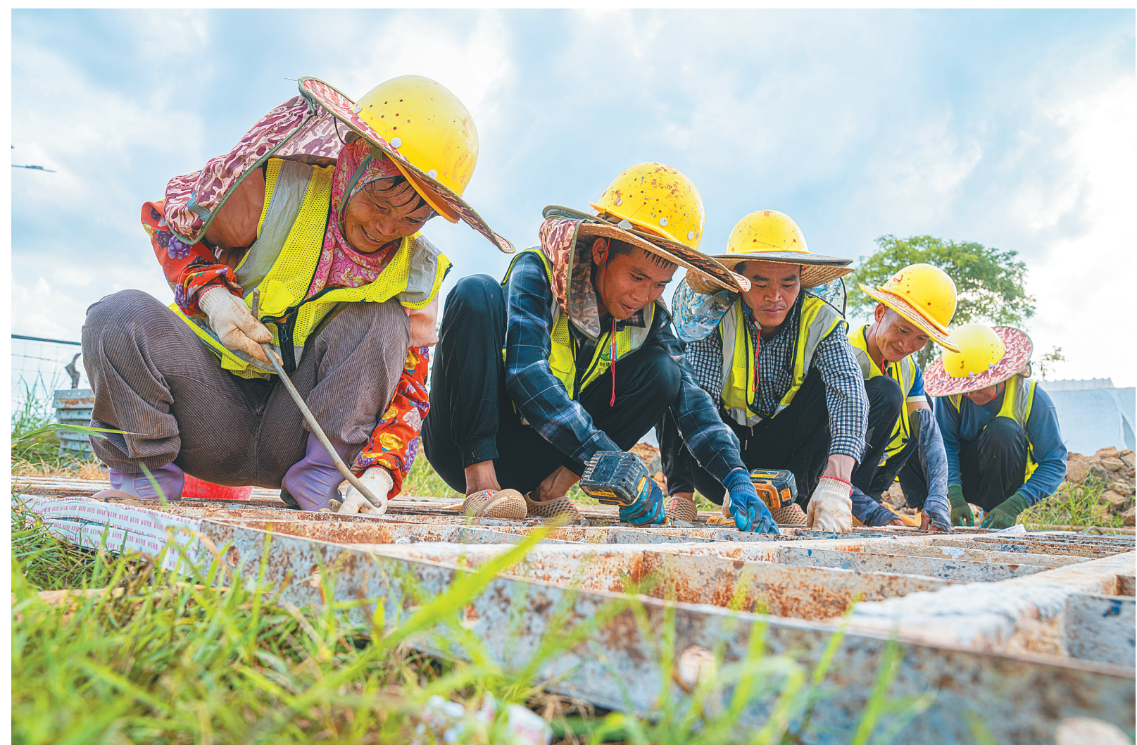
南渡江防洪堤工程(定安巡崖村段)施工进度达40%
