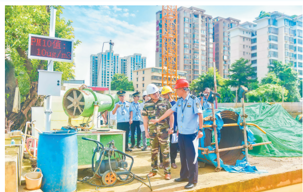
7月16日，海口市综合行政执法局龙华分局联合龙华区住建局、区水务局、区审批局，对海口华润中心四期项目在建工地开展“综合查一次”执法检查。
