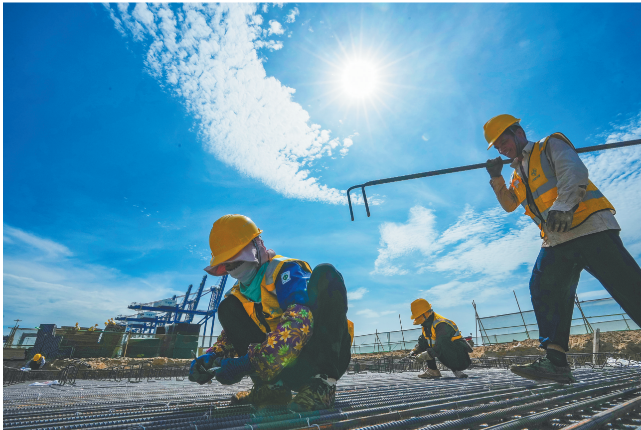
洋浦区域国际集装箱枢纽港:扩建工程进入施工高峰阶段
