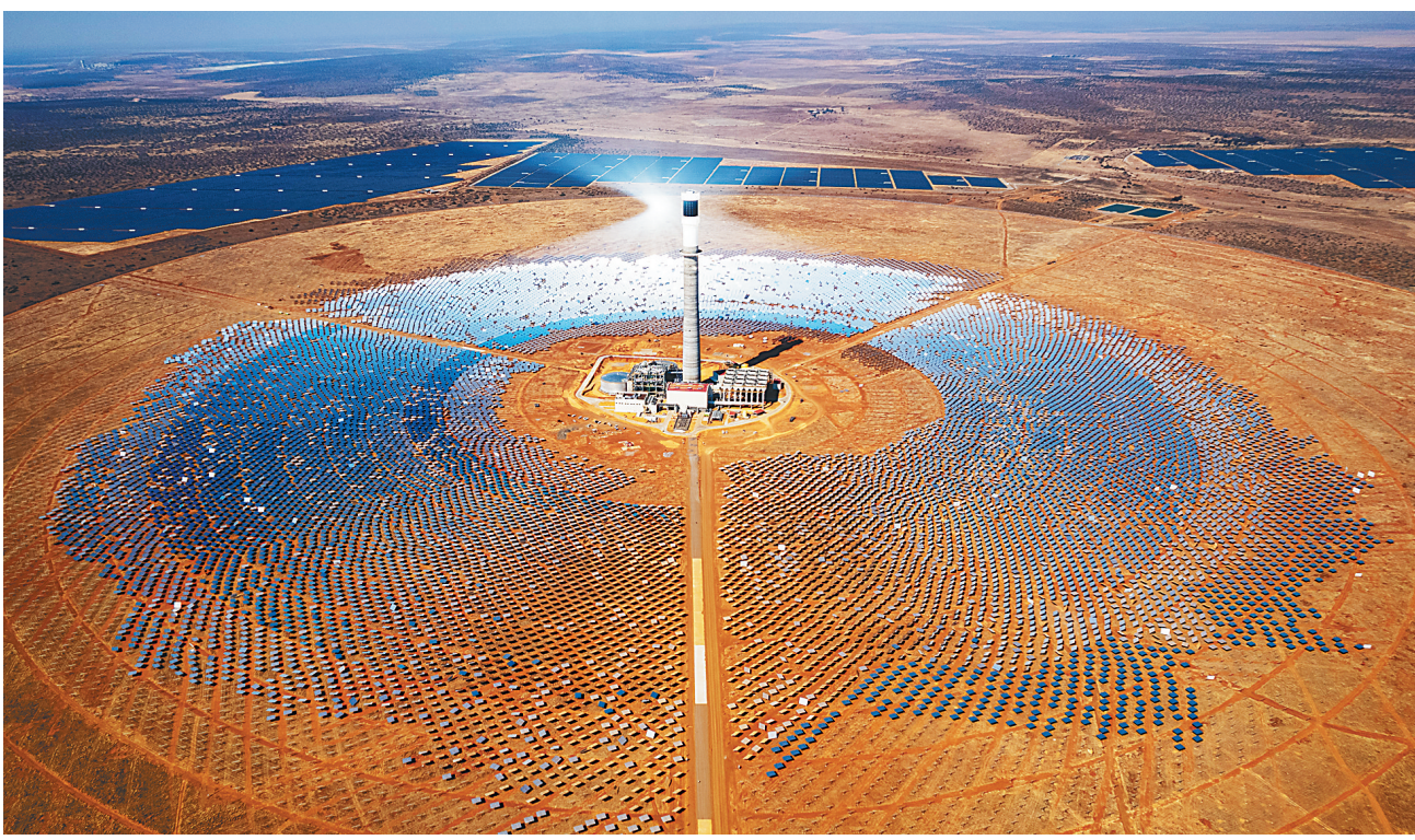
图为由中方建设的南非红石100兆瓦塔式熔盐光热电站项目。
