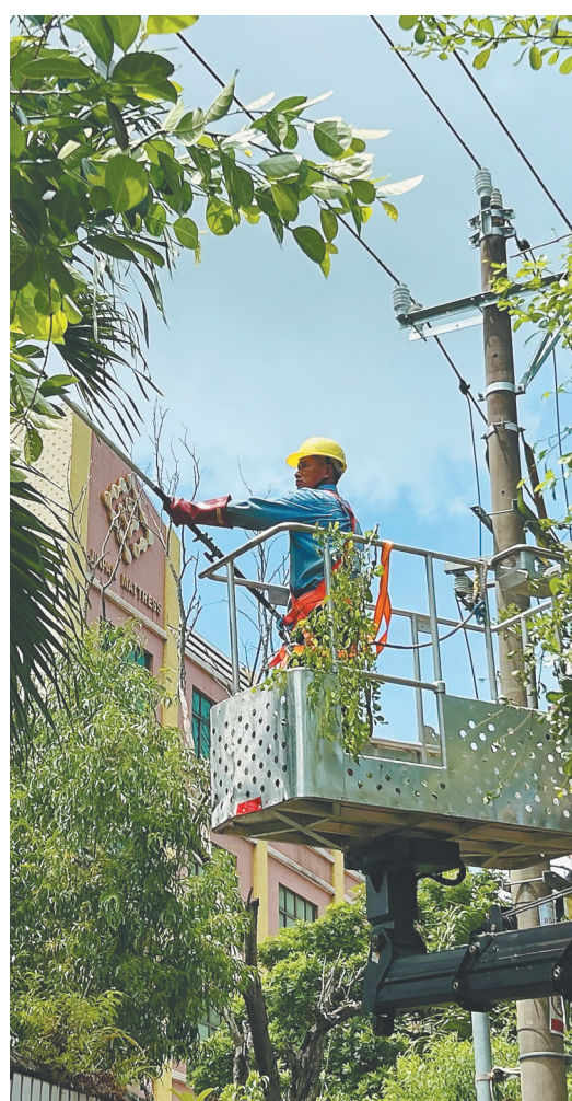
9月4日,海南电网公司海口供电局组织施工人员对电力线路走廊开展树障清理工作。 杨永光 摄
