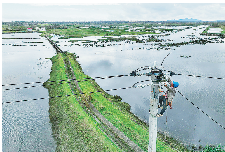
近日，在文昌市冯坡镇，供电部门工作人员正在加紧抢修通往镇区和海岸水产养殖区的线路。
