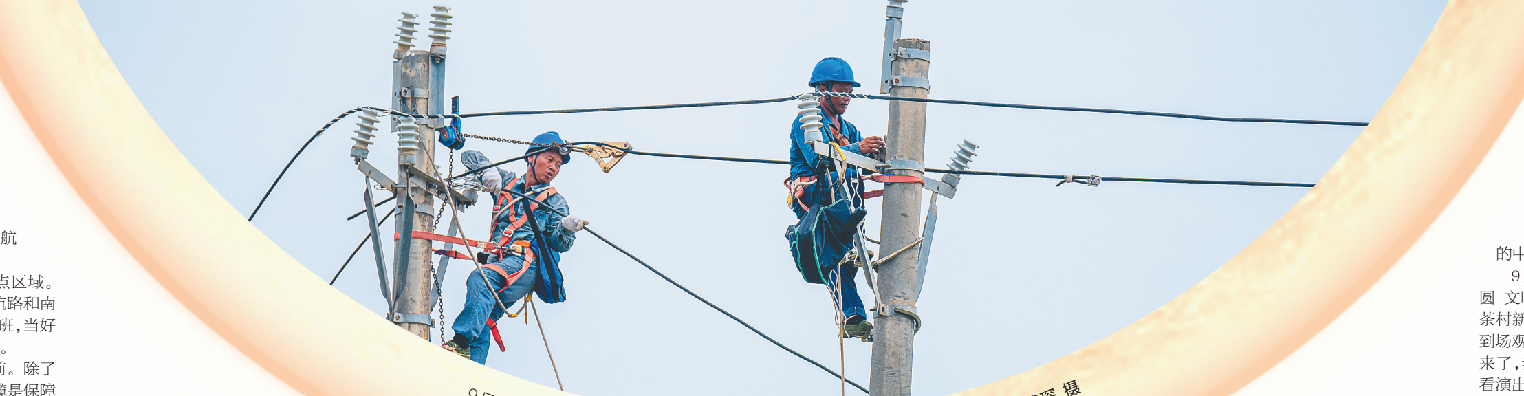
9月17日，在文昌翁田镇，电网工作人员加班加点抢修电路。海南日报全媒体记者 袁琛 摄
