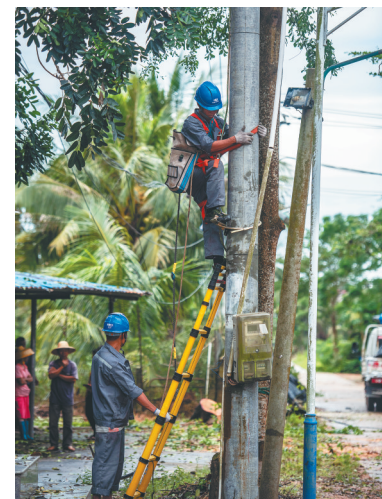
近日，电力工作人员在琼海市潭门镇社昌村抢修供电线路。 特约记者 蒙钟德 摄
