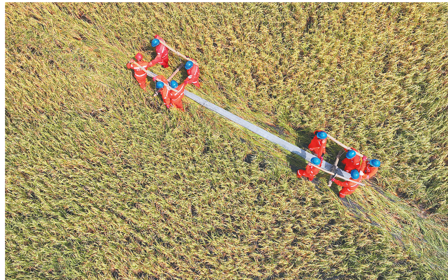
近日，在文昌市文教镇熔炉村，南方电网贵州电网六盘水供电局支援海南抢修人员穿过杂乱的草地，将电杆搬上高坡上的故障抢修点。 通讯员 王飞 卢欣 图文
