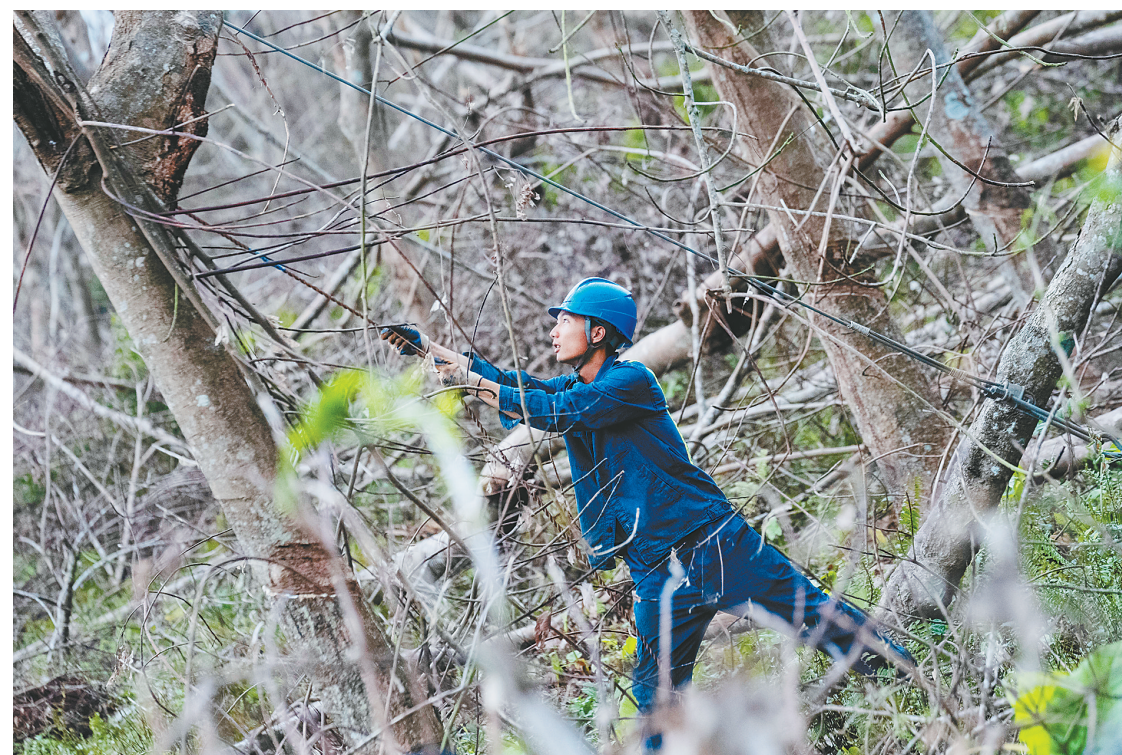
▲9月19日，在海口市琼山区红旗镇云山村附近，南方电网广东肇庆供电局支援海南抢修人员穿过倒伏的树木，将导线拉上电线杆。
