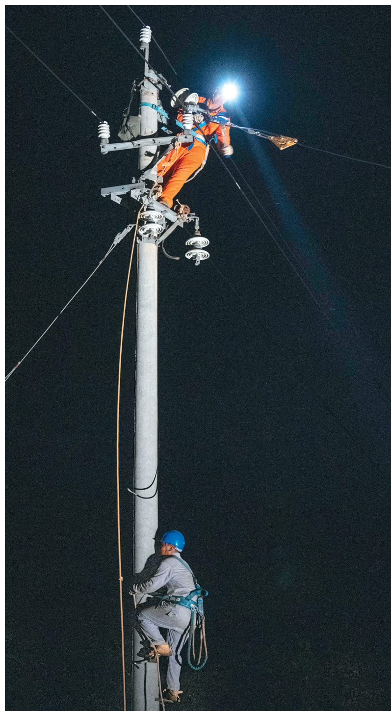
9月18日，在海口市美兰区三江镇道美村，来自广东茂名的电力抢修人员冒雨登上电线杆，重新架设上新的绝缘导线。
