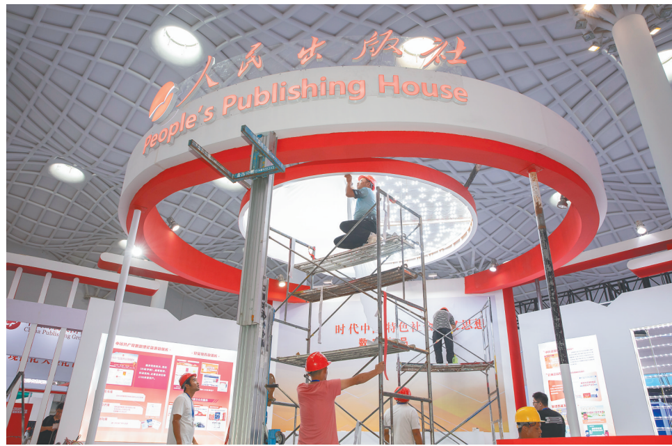
9月20日下午，人民出版社展位，工人加紧搭建展台。本组照片均由海南日报全媒体记者 陈若龙 摄
