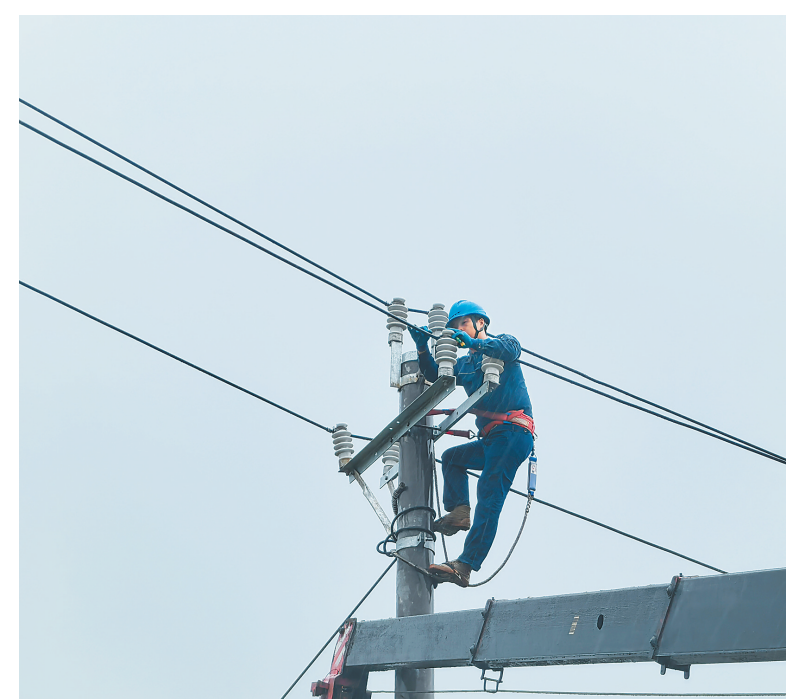
昌江供电局作业人员冒雨抢修受损电路。海南日报全媒体记者 高懿 通讯员 许家俊 摄
