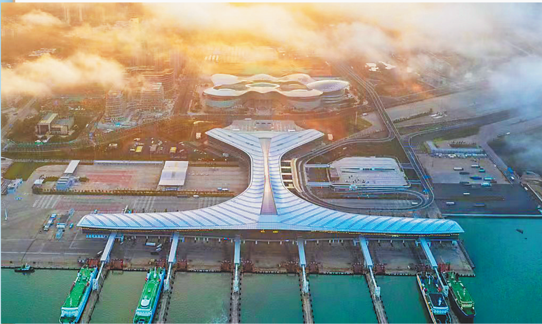
航拍位于海口市秀英区的全国最大的港口客滚综合枢纽——海口新海港装码头客滚综合枢纽站项目。
