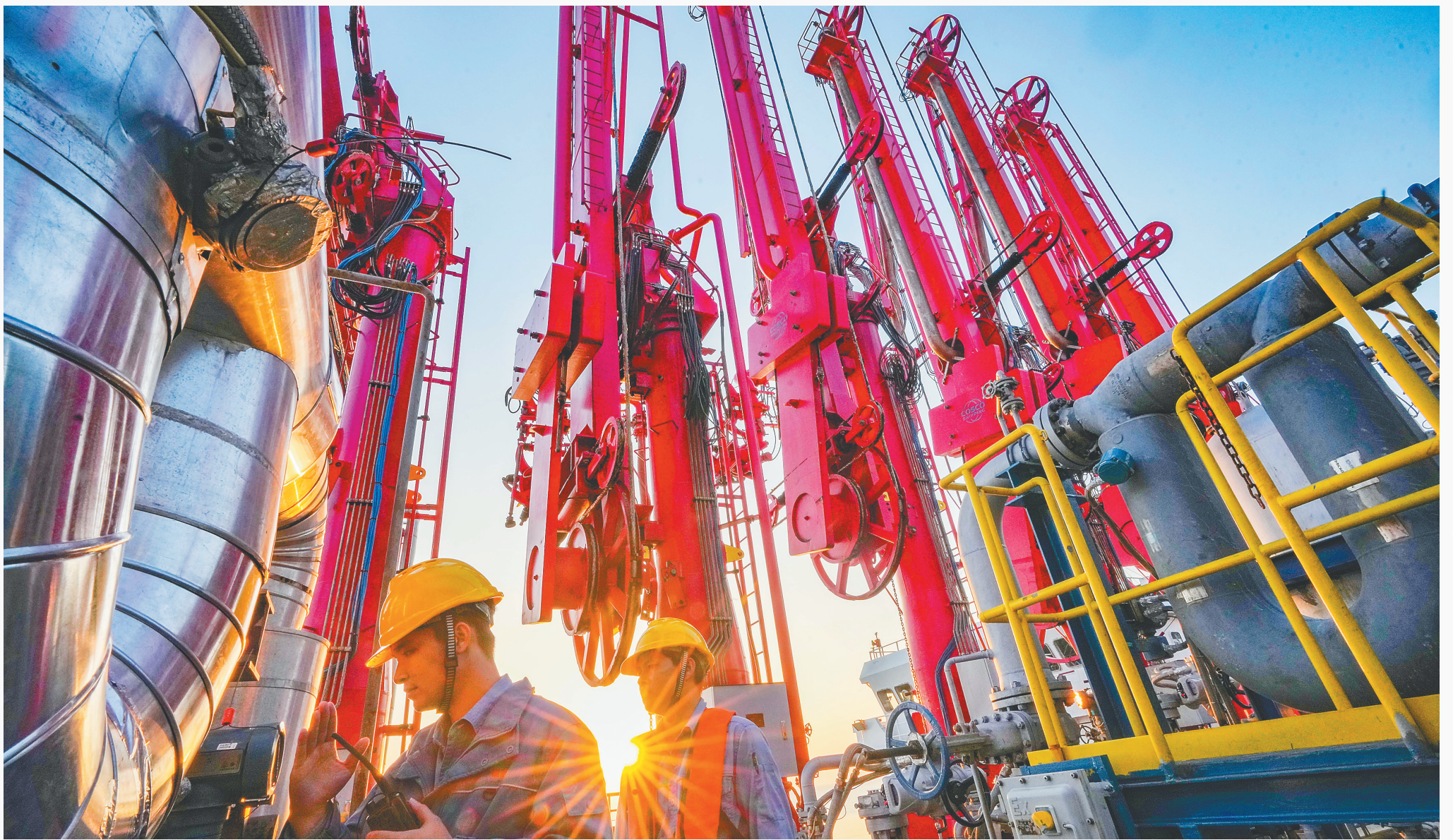
在海南炼化公司百万吨乙烯项目配套码头，工作人员在装卸物料。海南日报全媒体记者 陈元才摄
