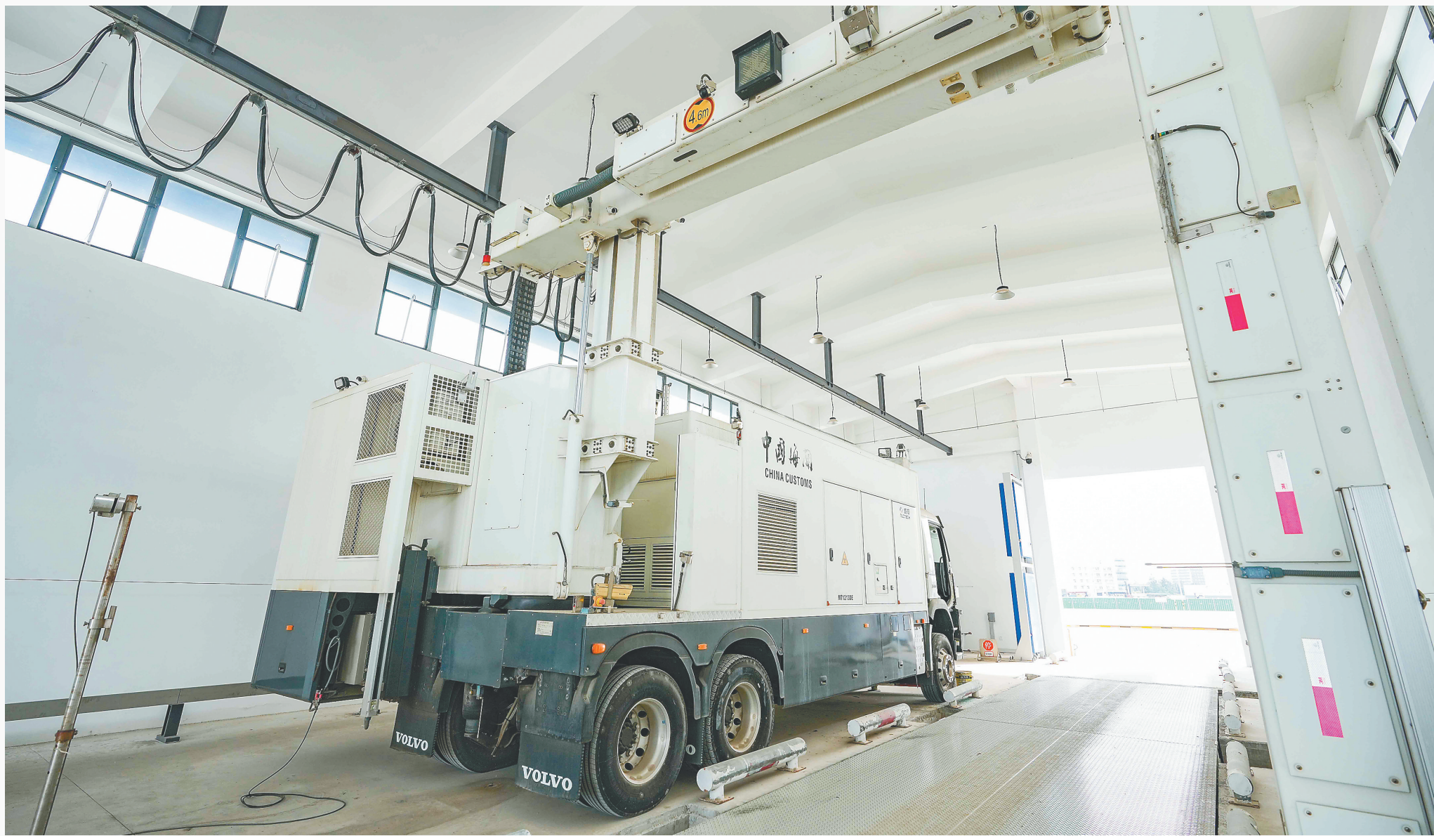
洋浦港封关运作项目建设现场，一设备在进行调试。海南日报全媒体记者 陈元才摄
