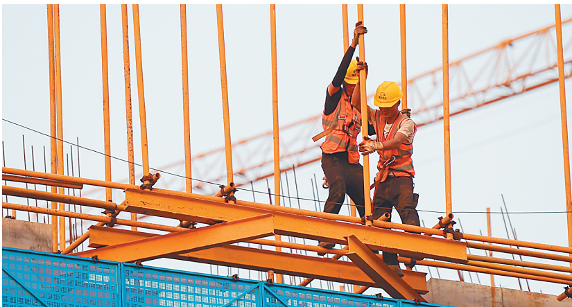
在海口江东新区海控·江东广场项目现场，工人正在加紧施工建设。 海南日报全媒体记者 张茂 特约记者 王聘钊 摄
