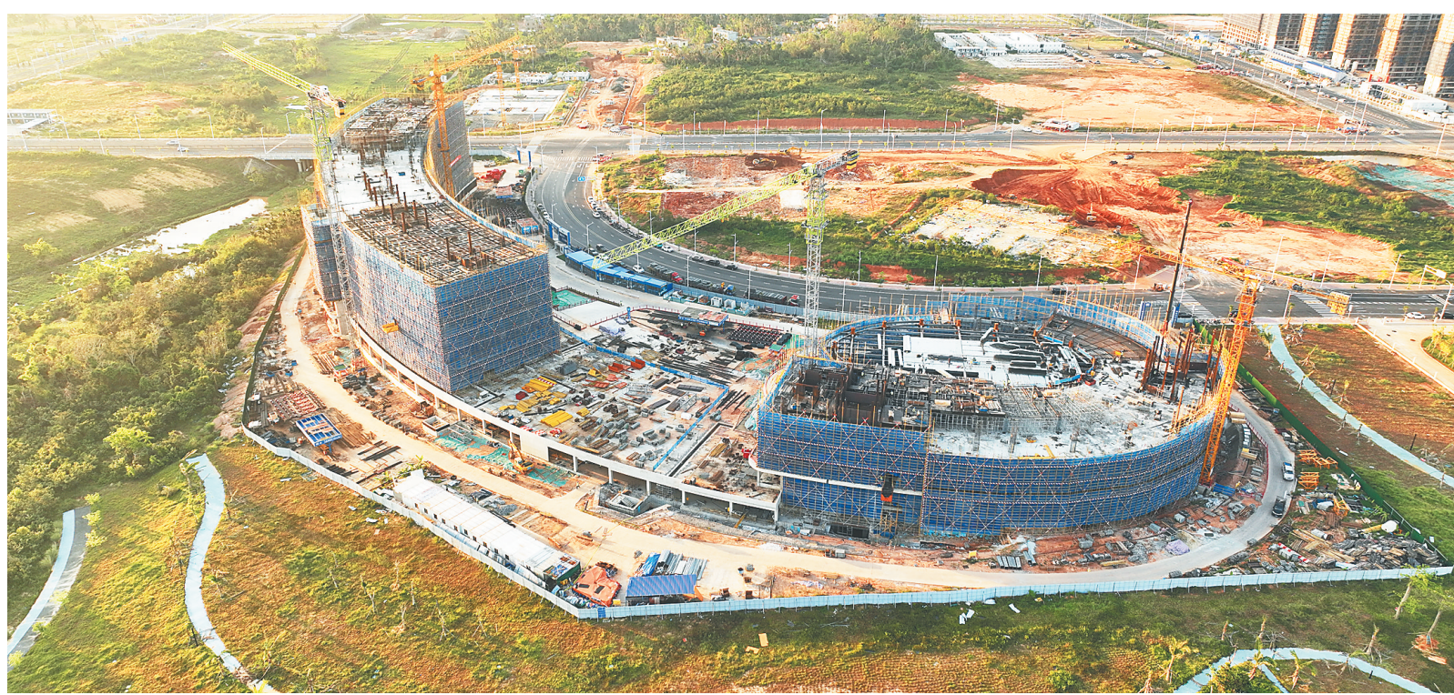
10月3日，在文昌国际航天城起步区开发建设项目一期航天科创基地项目现场，各项施工有条不紊推进。海南日报全媒体记者 刘梦晓 通讯员 韩彩虹 摄
