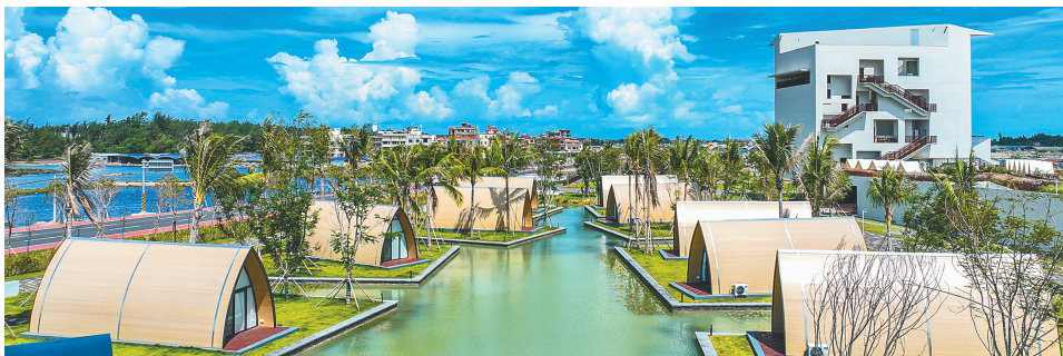
海南环岛旅游公路莺歌踏浪驿站。海南日报全媒体记者 张茂 摄
